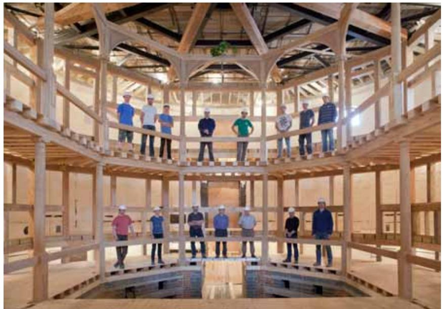
Рисунок 5. команда дизайнеров и плотников МакКерди в лесах деревянной каркасной конструкции сцены яковианского Театра перед строительством сидений, поручней, панелей и заполнением задней стены фахверка.
