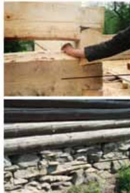
Рисунок 4. Конструкция стены сруба на каменной основе
